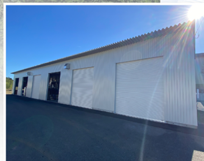
<リサイクル集積倉庫 2022年3月竣工>
